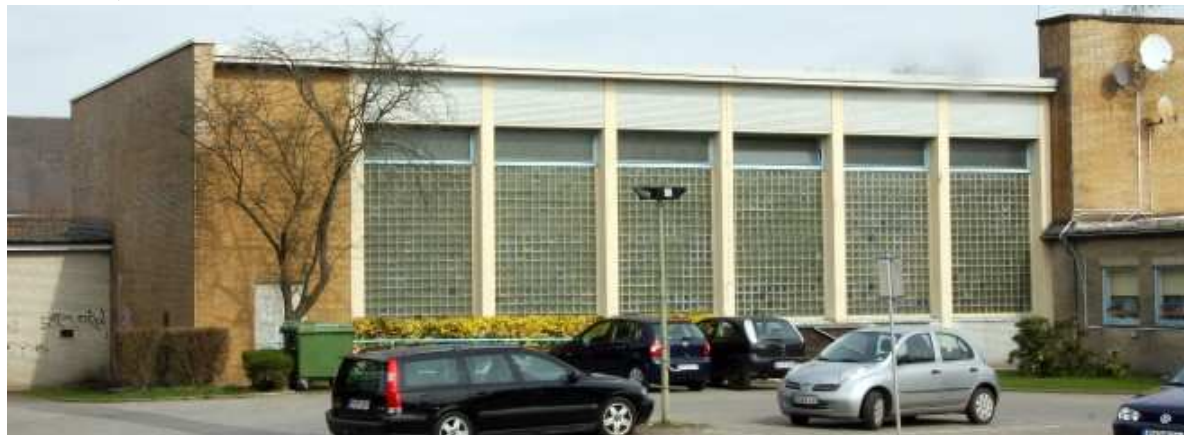
Neubau mit Schule statt Anbau: die Märkische Halle neben dem Hallenbad in Annen. Foto: Walter Fischer
